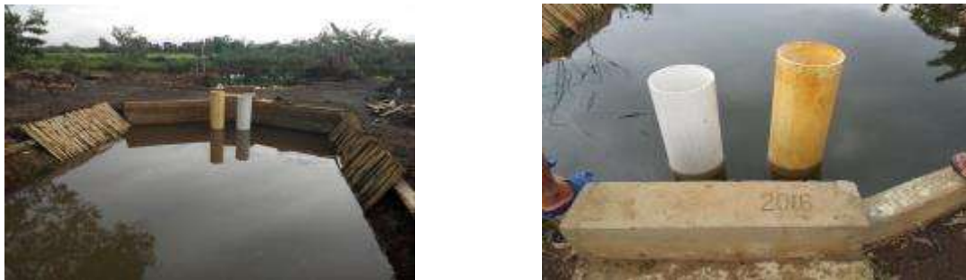
Gambar 3.6. Pintu air pada saat menahan air (a) dan pintu beroperasi drainase terkendali (b)
