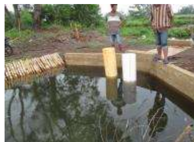
Gambar 3.11. Pipa leher angsa di operasikan untuk menahan air
