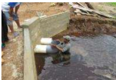
Gambar 3.11. Pipa leher angsa di operasikan untuk menahan air
