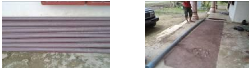
Gambar 4. Pipa berlubang siap dipasang dilapangan
