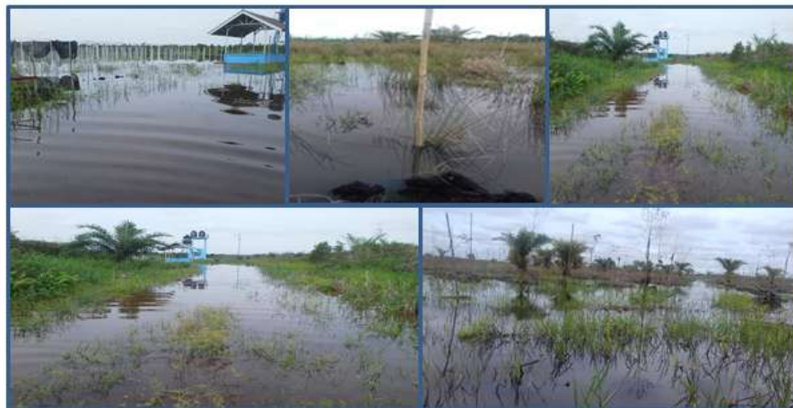
Gambar 4. Kondisi genangan di lokasi Kebun Raya Sriwijaya saat musim hujan
